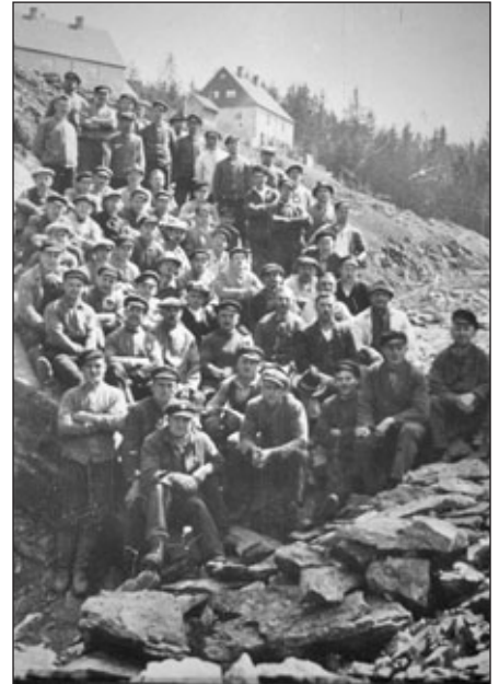
Ausbau des Hemmbergweges, Notstandsbaue um 1935. Links oben zwei Doppelhäuser der 1934 fertiggestellten Randsiedlung (Sammlung Pfarrarchiv Bockau).
